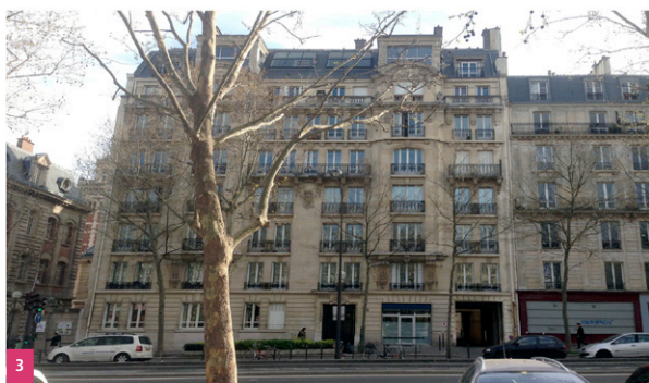
Des types architecturaux étudiés, du pavillon à l'immeuble de ville (photos 1 et 3 Sabri Bendimérad, photo 2 Monique Eleb)
