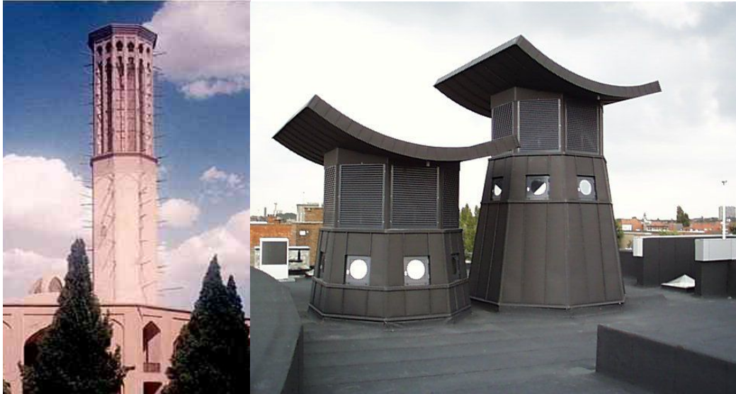
Figure 4- 8: Exemple de cheminée de ventilation traditionnelle ( leYazd iranien) et solutions modernes (IVEG building, Renson 2004)
