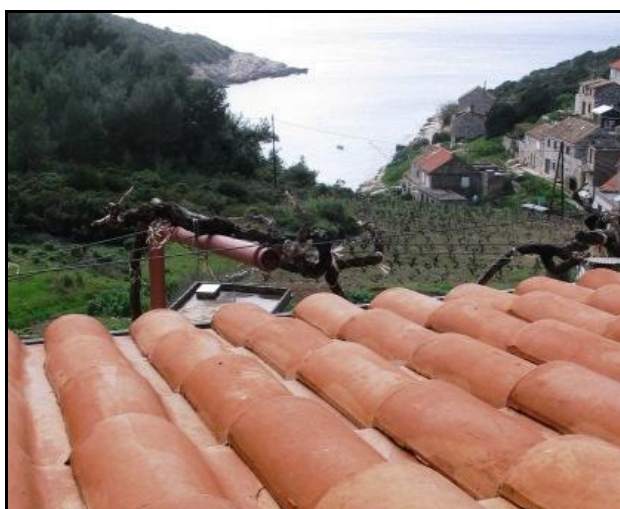
Fig.IV.10. Toit de tuiles romaines de terre cuite typique des maisons construites sur la côte dalmate. (photo O. Clus)
