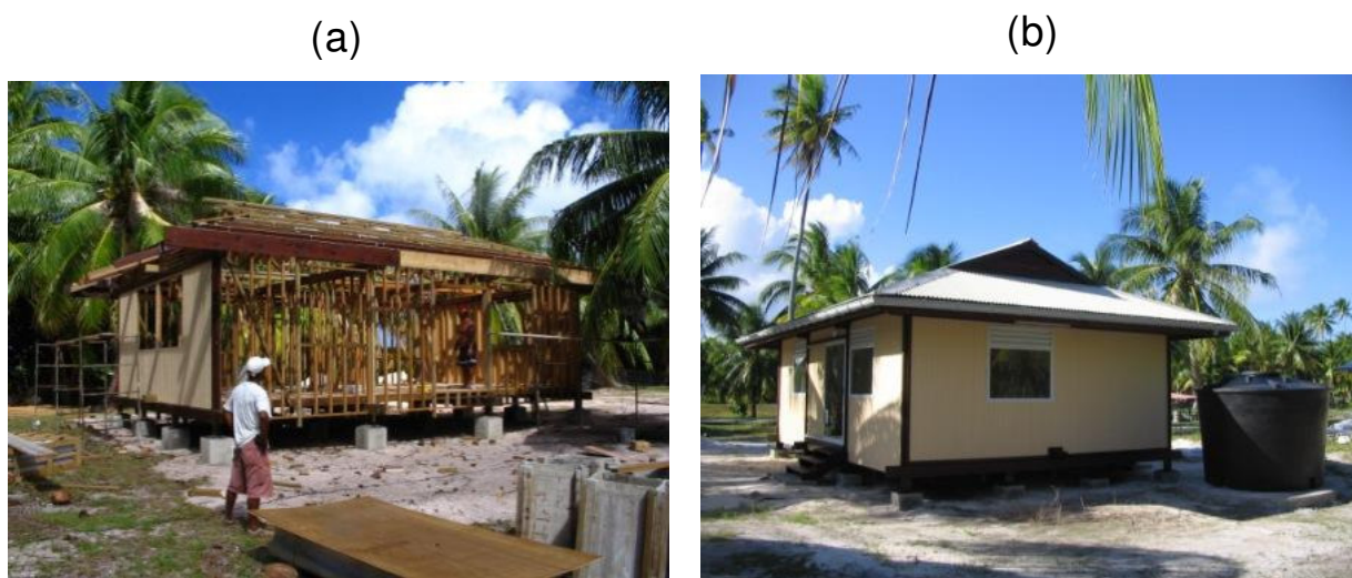
Fig.IV. 13. (a) Montage d'un fare MTR (Tikehau, 2005); (b) Fare MTR et citerne de stockage des pluies attenante. (photo O. Clus)
