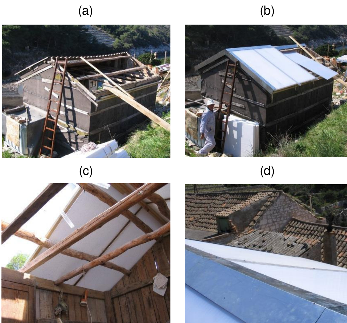
Fig.IV.6. (a) Démontage de l'ancien fibrociment ; (b) installation des nouvelles plaques de polycarbonate ; (c) positionnement de l'isolation de Polystyrène expansé ; (d) éléments de faîtière en acier galvanisé. (Photo O. Clus)
