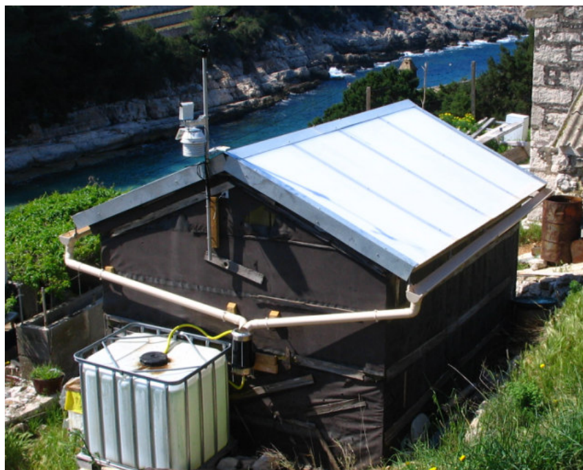
Fig.IV.7. Vue d'ensemble du collecteur de rosée de démonstration en toiture à Bisevo : condenseur, gouttières et station d'acquisition des données. (photo O. Clus).
