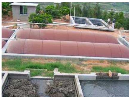
En Chine il existe depuis quelques années des digesteurs souples en toile spéciale. Ces digesteurs sont adaptés pour la matière liquide.
