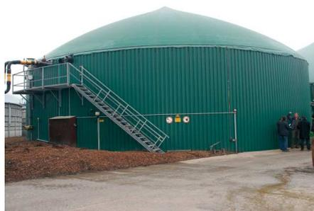
En Europe, il existe des modèles de plusieurs centaines de m<sup>3</sup> avec un gazomètre souple.
