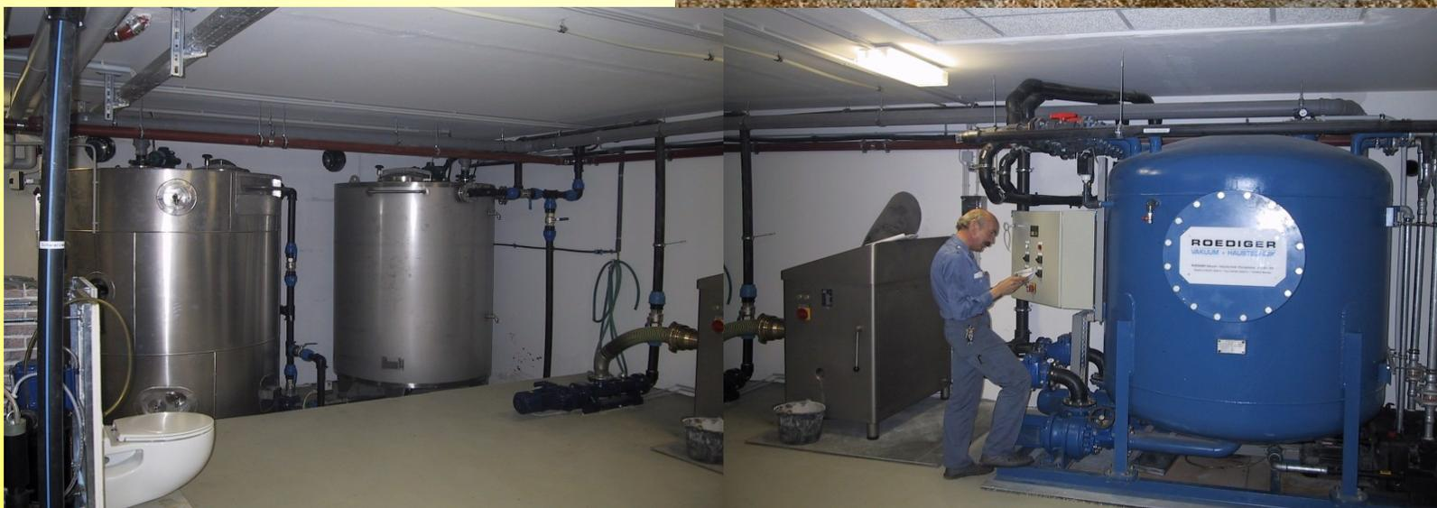
8 cabines de WC, évacuation séparée d'urine, des eaux de lavage et de la matière fécale, co-compostage de la matière fécale + papier et des déchets organiques, utilisation des urines et eaux de lavage pour la fertilisation et l'irrigation des bananeraies
