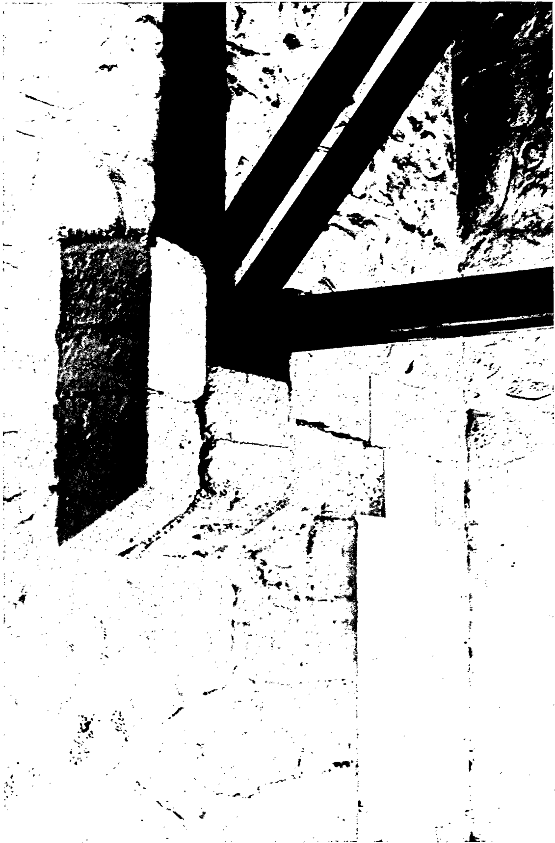
Fig.28 : Niğde - Ecole rurale - Détail d'une console support de ferme (photo A. Gülgönen).
