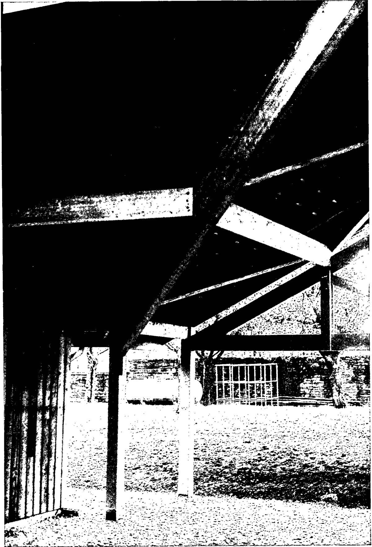
Fig.38 : Clessé - Ecole maternelle - Vue de la charpente du préau (photo S. Abdulac).
