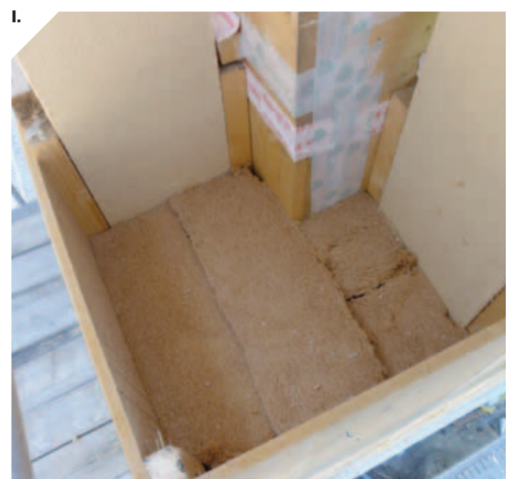
I. VUE DE L'ISOLATION (AVANT REMPLISSAGE AVEC DE LA CELLULOSE).
