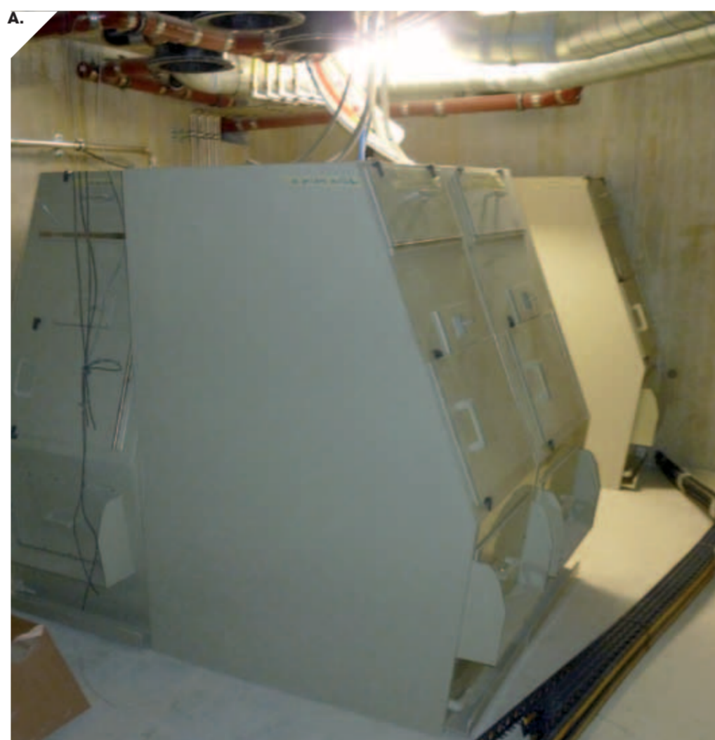
A. VUE DES COMPOSTEURS AU SOUS-SOL.
