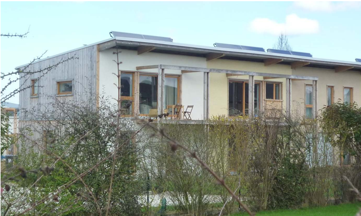
Figure 15 : Vue depuis l'extérieur de logements des Z'Ecobatisseurs, mars 2012, ACK
