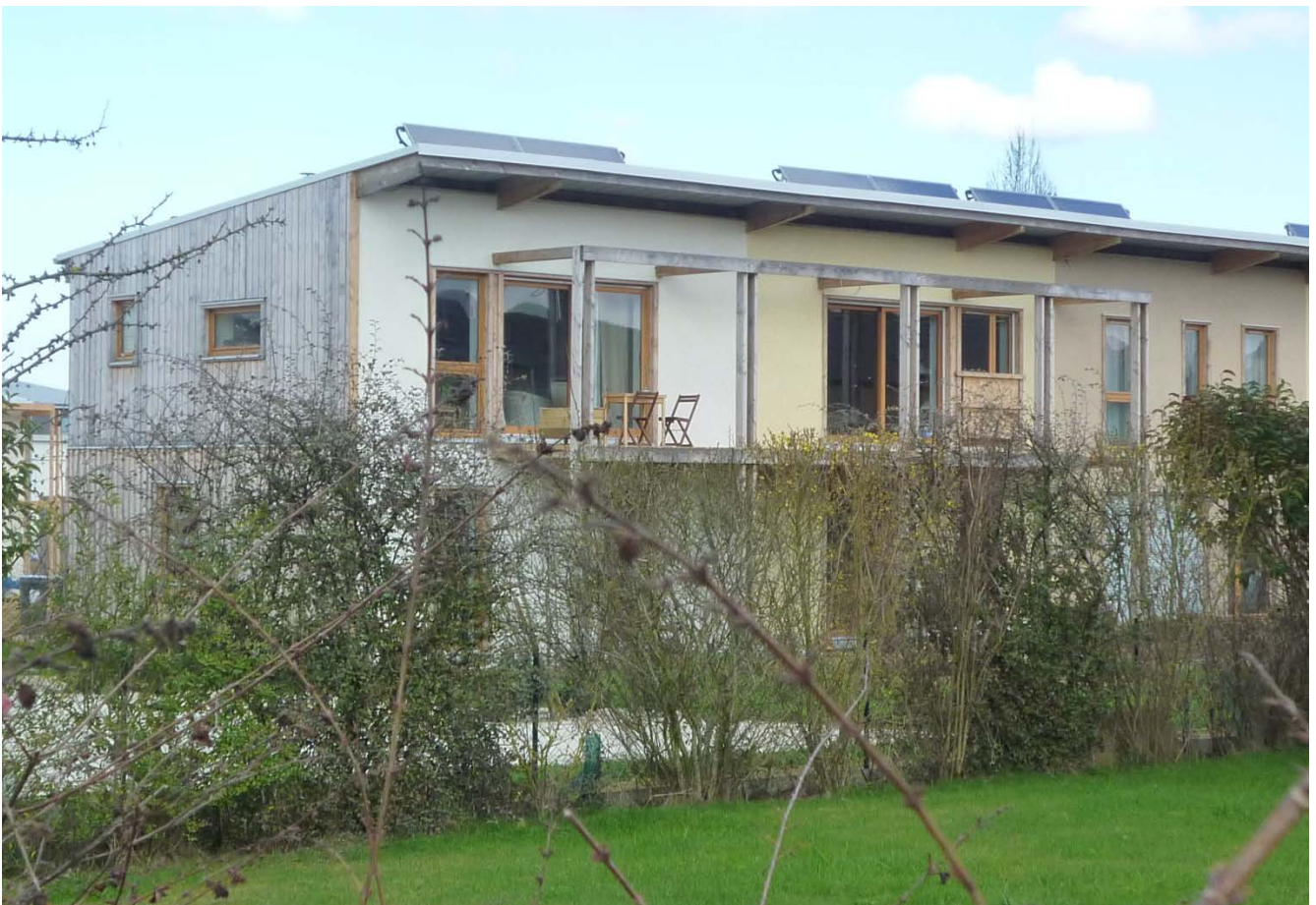
Figure 19 : Vue du Sud depuis l'extérieur des logements Sud, 20 mars 2012, ACK
