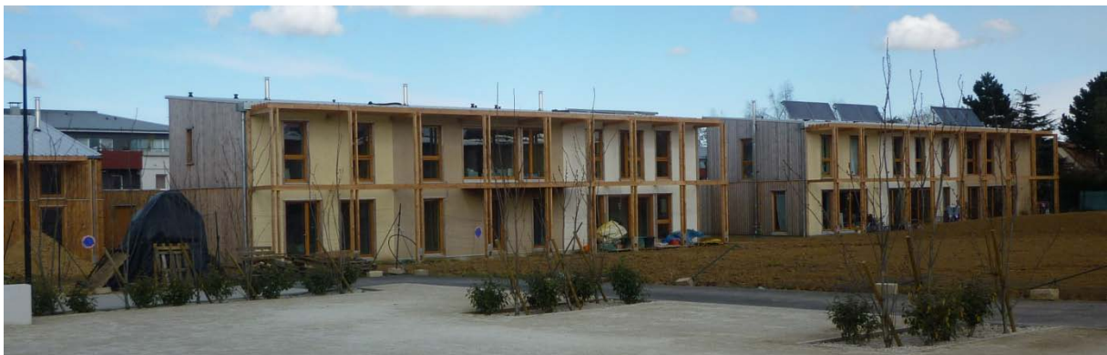
Figure 32 : Vue sur les logements Nord des Z'Ecobatisseurs depuis la rue, mars 2012, ACK
