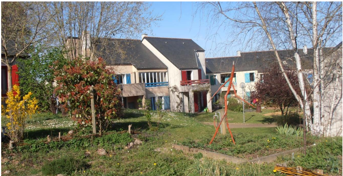
Figure 20 : Vue sur des logements et le potager d'Habitat Différent depuis la cour intérieure, mars 2012, CD 29
