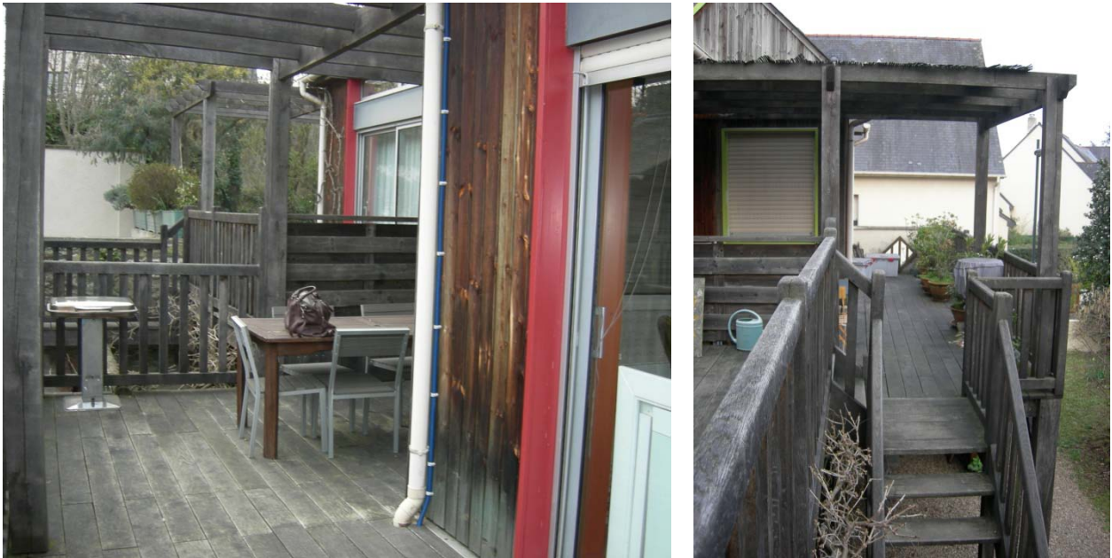
Figure 31 : Vue sur les terrasses individuelles des habitants de La Petite Maison, mars 2012, ABG
