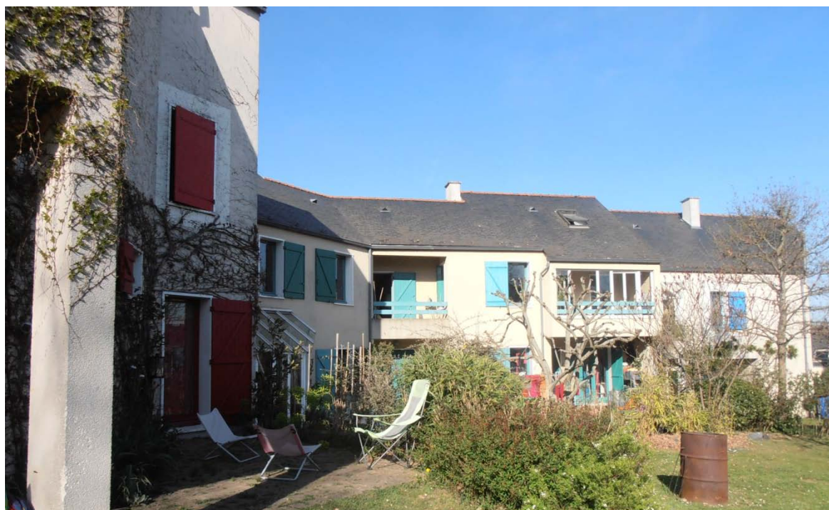
Figure 18 : Vue de logements d'Habitat Différent depuis la cour intérieure, mars 2012, CD
