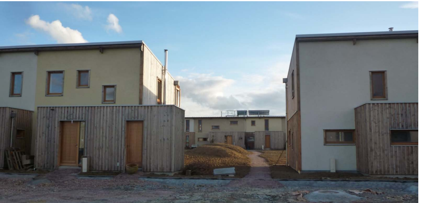
Figure 23 : Vue depuis le Nord du terrain des Z'Ecobatisseurs, 20 mars 2012, ACK
