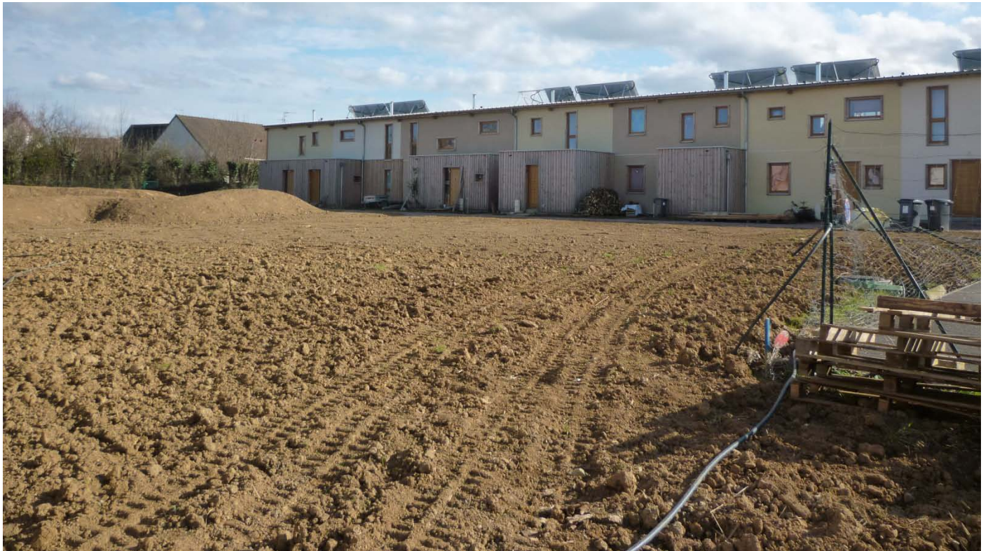
Figure 22 : Vue sur les logements Sud et le jardin depuis le Nord, 20 mars 2012, ACK
