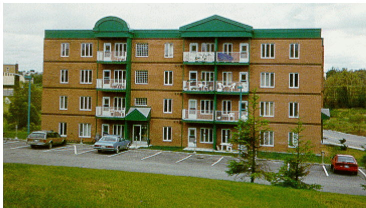
Illustration 6 Exemple d'immeuble à logements du secteur public
