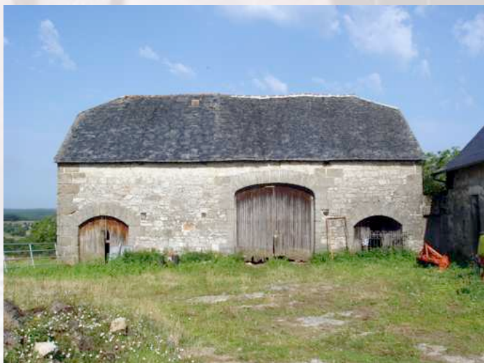
Sur le Causse, le manque de bois d'oeuvre donnait lieu à des maçonneries très soignées, avec de beaux arcs en pierre de taille ( grès ou calcaire).
