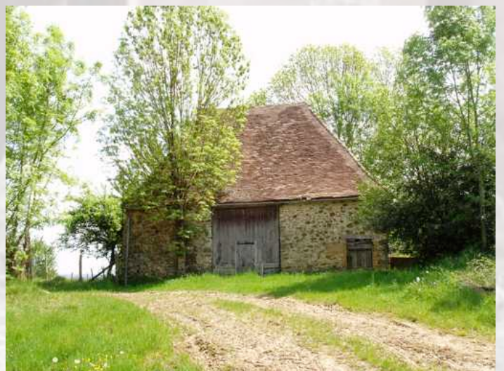
Dans la vallée de l'Auvézère, au contact de la Dordogne et de la Haute-Vienne, les granges “limousines” se généralisent, avec de hautes toitures à croupes couvertes de tuiles. Les encadrements de baies en bois consolident des maçonneries précaires en pierre “tout-venant”.
