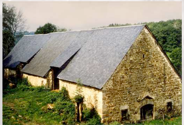
“Dômes-Sancy” portes charretières en mur gouttereau nord ; portes d'étables en pignon ; couloir longitudinal et axial ; fenestrous d'aération en mur gouttereau sud.
