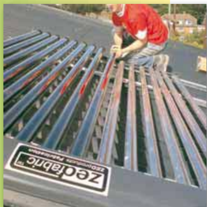
L'eau est principalement chauffée par l'énergie solaire
