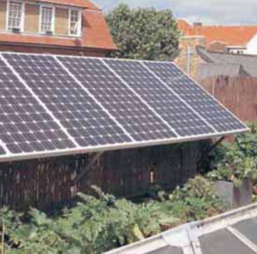
25m 2 de panneaux solaires sur le toit
