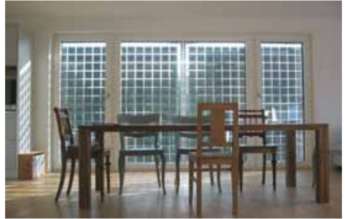
La puissance totale des divers éléments photovoltaïques de cette maison individuelle se monte à 3,1 kW. Source: R. Miloni, Mülligen.
