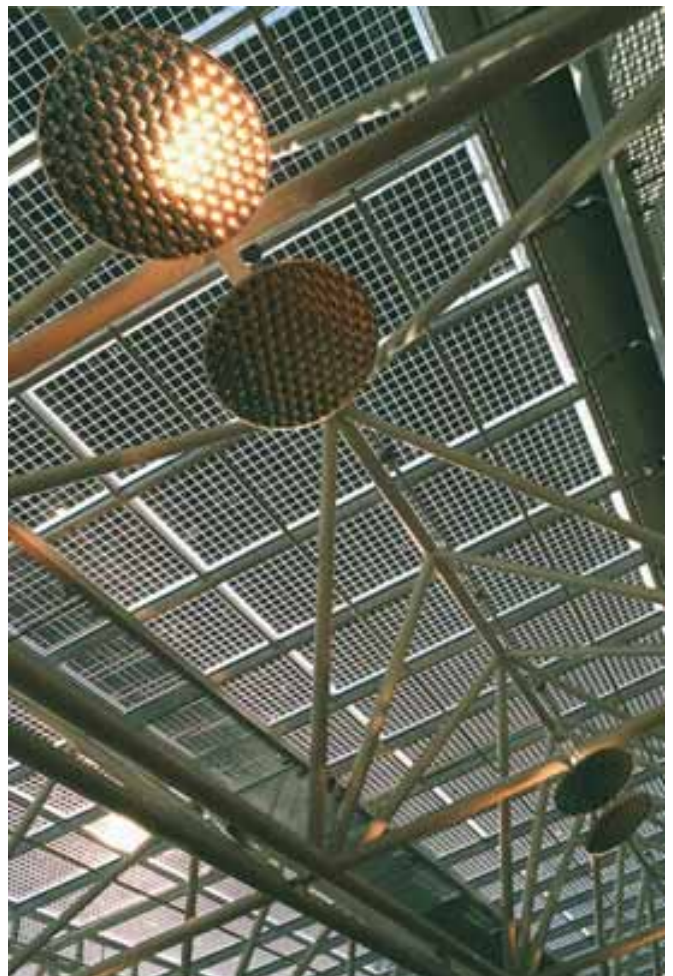
Illustration 36: Centre commercial à Zurich. Le toit du hall comprend une installation photovoltaïque (30kW), intégrée au verre isolant, qui alimente les entreprises électriques de la ville de Zurich (ewz). Source: energiebüro Zürich.
