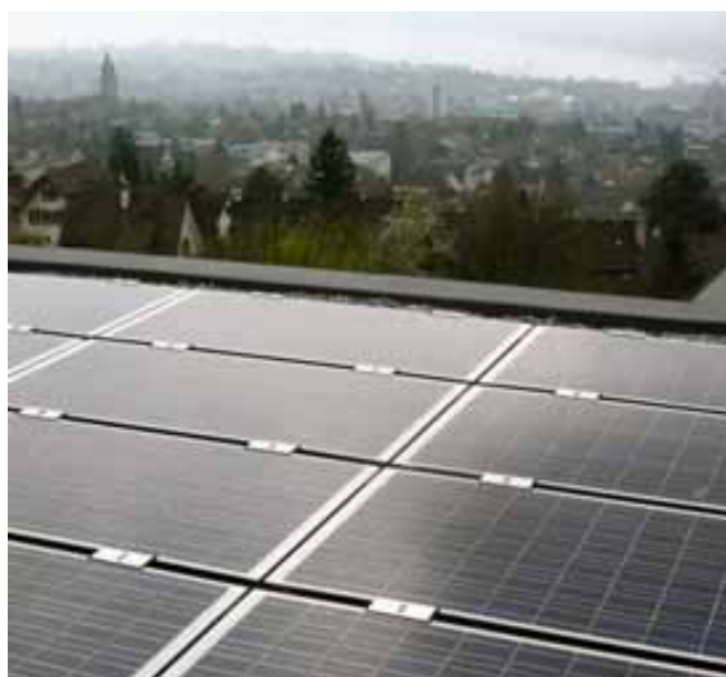
Illustration 96: Installation photovoltaïque sur le toit plat d'une maison individuelle à Zurich. Puissance de l'installation: 5,76 kW. Source: BE Netz, Lucerne.
