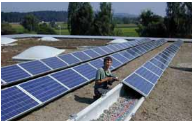
Illustration 28: Un centre d'entretien de Gossau (SG) fournit du courant à la commune. Celle-ci propose du courant photovoltaïque à ses habitants par l'intermédiaire de ses services industriels. L'installation peut aussi alimenter un véhicule électrique des services industriels. Source: services industriels de Gossau.
