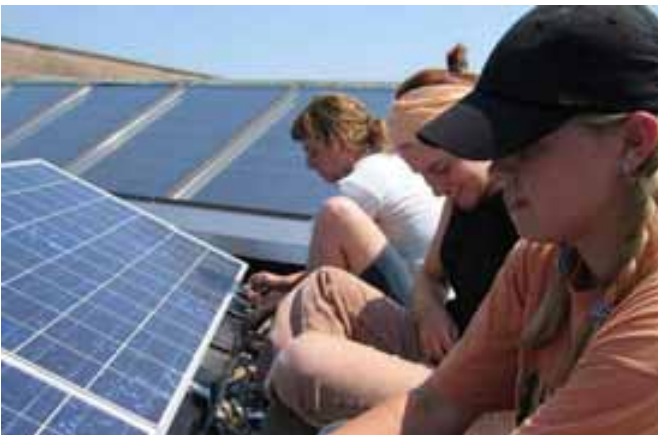
Illustration 25: Des élèves montent une installation photovoltaïque sur le toit d'une salle de gymnastique à Kreuzlingen (TG) . Nadin Bill a réalisé ce projet dans le cadre de son travail de diplôme. Source: N. Bill, Kreuzlingen.
