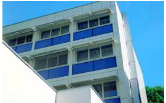
Illustration 49: Bâtiment administratif de Gastro Ticino à Lugano, avec des pare-soleil photovoltaïques. Les cellules solaires sont montées sur des panneaux mobiles. Leur orientation automatique remplit deux fonctions: faire de l'ombre aux fenêtres et orienter les cellules de manière à optimiser le rendement énergétique. La façade comprend aussi des capteurs solaires (thermiques, en bleu). Source: B. Gerber, SSES, Berne.
