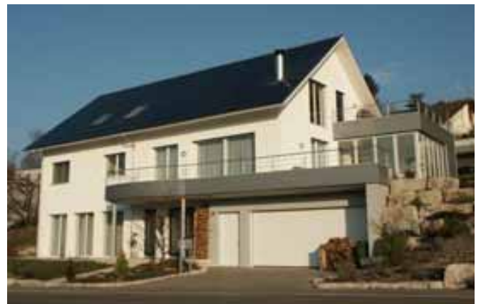
Illustration 51: Maison individuelle à Untersiggenthal (AG) avec installation photovoltaïque couvrant tout un pan de toit. En moyenne annuelle, la production de l'installation dépasse d'environ 15 % les besoins totaux d'énergie de la maison (chauffage et eau chaude inclus). Source: G. Erni, Untersiggenthal.
