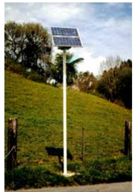
Illustration 6: Lampadaire autonome. De la lumière sans raccordement au réseau près du lac de Wohlen (BE). Source: M. Gutschner, Fribourg.
