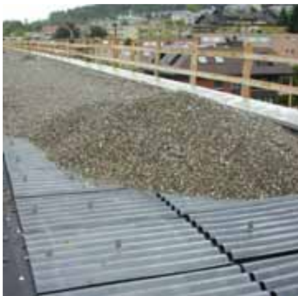
Illustrations 61 à 63: Montage à Pfäffikon (SZ). Les trois étapes du montage d'une installation photovoltaïque (32 kW) sur le toit plat végétalisé de l'immeuble
