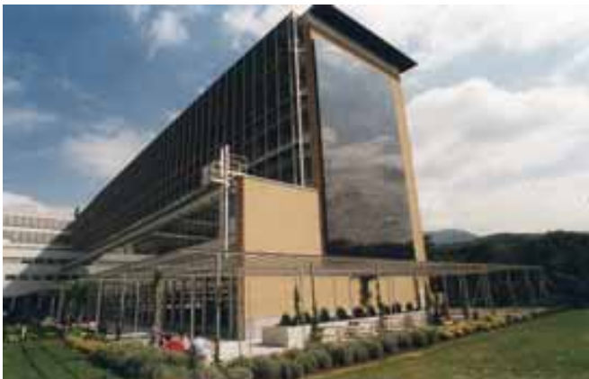
Illustration 48: Bâtiment administratif à Manno (TI), avec un concept énergétique incluant le photovoltaïque. Le nouvel édifice de l'UBS est un modèle du point de vue écologique et énergétique. Les divers modules de l'installation photovoltaïque, répartis sur différentes surfaces de l'enveloppe du bâtiment, ont une puissance totale de 183 kW: 102 kW sur le toit plat, 47 kW sur les pare-soleil et 34 kW sur les deux façades sud. Source: Enecolo, Mönchaltorf.
