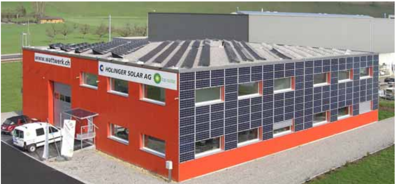
Illustration 39: À Bubendorf (BL), le bâtiment industriel WATTWERK est le premier au monde à produire davantage d'énergie qu'il n'en consomme. Chauffage, eau chaude, lumière, informatique et véhicules électriques: toute l'énergie provient du bâtiment. Celui-ci est très bien isolé (solaire passif, technique Minergie) et particulièrement économique. L'installation photovoltaïque produit
