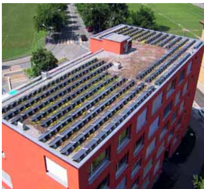
Illustration 125: Solution superposée à un toit végétalisé à Zurich. La structure de montage Solgreen offre une solution intéressante (distance par rapport à la surface, fixation du support sur le toit) sur ce bâtiment de la « Zürcher Wohn- und Baugenossenschaft ». Source: NET, St-Ours.
