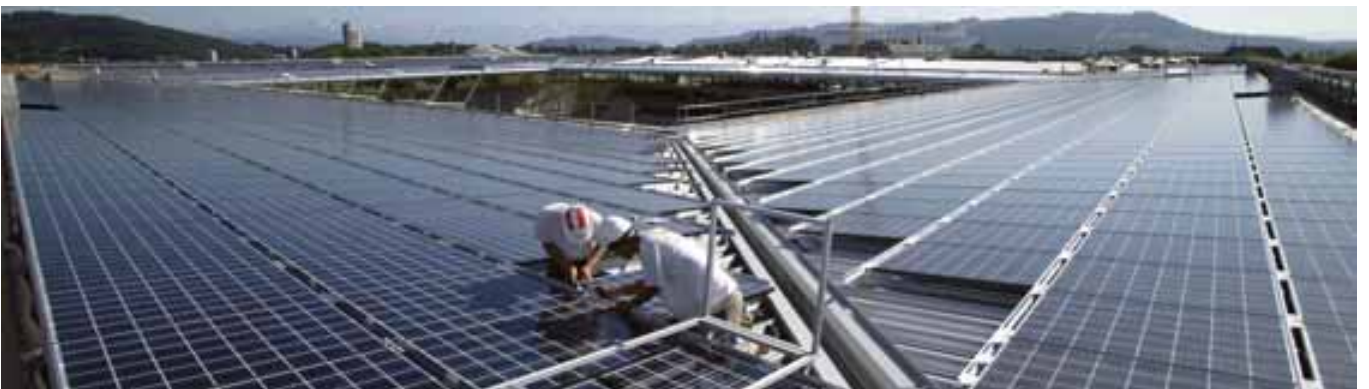
Illustration 27: Stade de Suisse à Berne . L'installation produit, en moyenne annuelle, de quoi alimenter 200 ménages suisses en électricité. Source: FMB.
