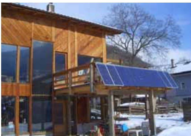
Illustration 115: Maison solaire BET-EL à Bitsch (VS). La famille Anthamatten mise sur l'efficacité énergétique et les technologies modernes. Sur la photo: une installation photovoltaïque autonome. Source: H-P. Anthamatten, Bitsch.
