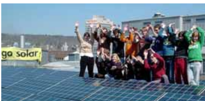
Illustration 134: Formation et parrainage écologique dans le domaine de l'énergie solaire. Les apprentis de Swisscom ont aidé à monter une installation photovoltaïque de 8,5 kW à Zurich (photo). Sur le plan du parrainage écologique: Swisscom achète du courant provenant de l'installation photovoltaïque du Stade de Suisse à Berne et l'offre au Festival du Gurten. Le bilan d'émissions de ce dernier est ainsi nul en matière de consommation électrique.
