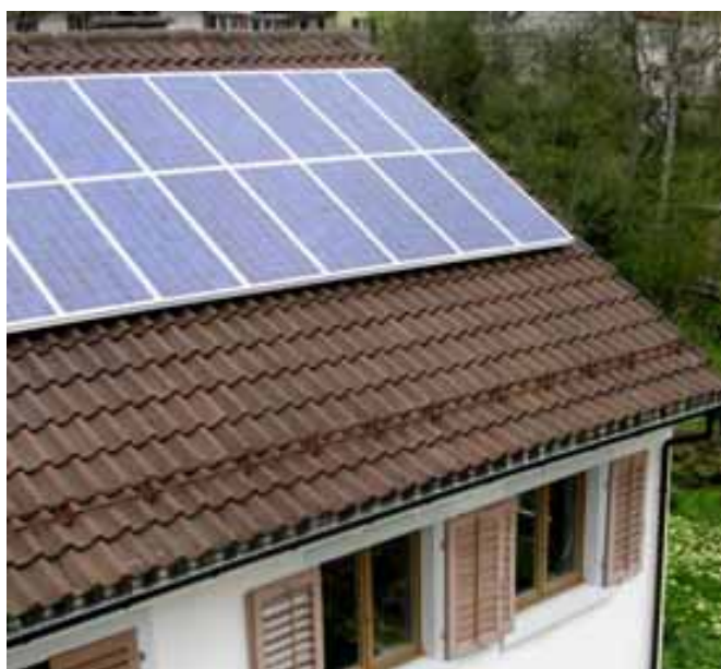
Illustration 95: Installation photovoltaïque sur le pan incliné d'un toit de maison individuelle à Zurich. Avec 3,3 kW, la puissance de cette installation est typique de cette campagne solaire. Source: BE Netz, Lucerne.
