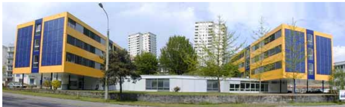
Illustration 32: Foyer pour étudiants « Rhodanie » à Lausanne. Le bâtiment de la Fondation Maisons pour étudiants frappe par sa composition particulière et ses couleurs vives. Il produit du courant photovoltaïque pour les Services industriels de Lausanne (SIL). Source: SIL.
