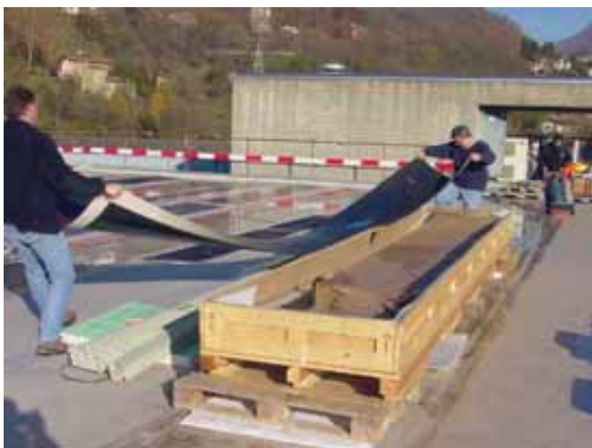
Illustrations 64 et 65: Membranes solaires flexibles. Des stratifiés photovoltaïques flexibles sont installés sur un toit. Le montage se fait selon les normes et les techniques habituelles. Les membranes sont sorties de la caisse de transport
