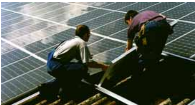
Illustrations 74 et 75: Installations photovoltaïques à Hünenberg (ZG). Une installation a été posée sur le toit d'une grange, l'autre sur un centre sportif.
