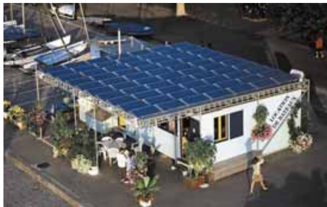
Illustration 29: La Rade Solaire à Genève. L'installation « Les Corsaires » fait partie de la Rade Solaire, qui inclut différentes applications du photovoltaïque le long de la rive urbaine du lac. Les panneaux de l'illustration alimentent un train touristique et plusieurs bateaux solaires. Source: ScanE.
