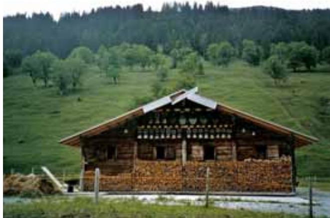
Illustration 126: « Intégration »: exemple critique dans le Richenbachtal. Ce chalet près de Rosenlaur (BE) attire tout d'abord le regard en raison de son aspect pittoresque et de sa collection de cloches. Mais on est ensuite dérangé par la manière dont a été fixé le module solaire central. N'est-il pas possible de mieux intégrer l'installation sans grande perte de rendement? Un arrangement symétrique avec un nombre pair de modules le long de l'arête du toit n'aurait-il pas un effet plus harmonieux? Source: M. Gutschner, Fribourg.
