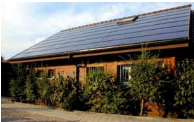
Illustration 30 et 31: Local des scouts « Weiermatt » à Köniz (BE). Le centre scout de Köniz utilise du courant photovoltaïque. La photo de gauche montre les panneaux solaires qui recouvrent tout un pan du toit du local. La photo de droite montre l'allocation des conseillères communales durant la fête d'inauguration.
