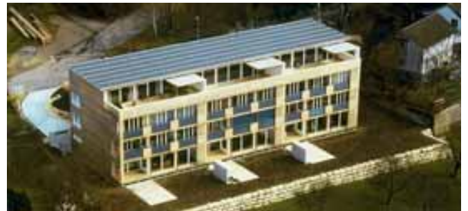
Illustration 38: Du photovoltaïque pour un immeuble produisant sa propre énergie de chauffage à Zurich Höngg. L'eau chaude et le chauffage sont fournis par la pompe à chaleur alimentée par l'installation photovoltaïque. Source: Beat Kämpfen, René Naef, Zurich.
