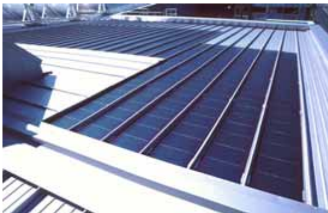
chété thermoplastiques pour les rendre résistantes et imperméables. Eurodach (exemple de Flums) est le nom donné à une combinaison de toit en tôle plissée et d'isolation thermique en laine minérale, que l'on peut équiper d'éléments solaires. Sources: Sarnafil, Sarnen / NET, St-Ours.
