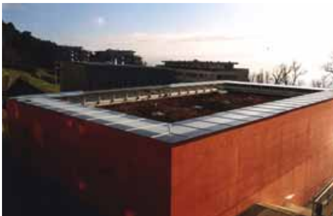
Illustration 112: Minergie et photovoltaïque à Neuchâtel. La salle de gymnastique Minergie de l'école des Acacias accueille les 69 m 2 de modules d'une installation photovoltaïque multifonctionnelle qui fait de l'ombre tout en produisant du courant. Source: Service de l'urbanisme de la ville de Neuchâtel.
