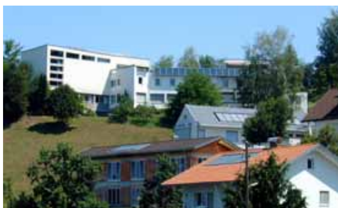
Illustrations 135 et 136: Installation photovoltaïque des citoyens à Zwischenwasser (Autriche). Sur le toit plat du centre de formation de Batschuns (en haut à gauche), une installation de 5 kW appartenant à 322 habitants (actionnaires solaires) a été montée en 1998. Le centre de formation accueille chaque année environ 15 000 visiteurs, qui entrent ainsi en contact indirect avec l'énergie solaire. À l'arrière-plan à droite, le toit de l'école obligatoire
