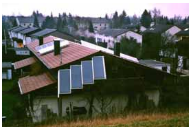
Illustration 127: « Intégration »: exemple critique à Krailling (Allemagne). Les habitants ont certainement voulu s'engager en faveur de l'énergie solaire. Mais on est en droit de se demander si les capteurs solaires et les modules photovoltaïques n'auraient pas pu être intégrés de manière plus esthétique. Le rendement énergétique supplémentaire dû à l'inclinaison plus marquée des surfaces justifie-t-il vraiment un pareil assemblage? Source: M. Gutschner, Fribourg.
