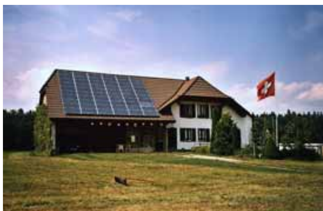
Illustration 123: Solution posée sur une partie d'un pan de toit. Ce bâtiment de Lyss (BE) comporte une installation posée sur le toit – qui a bénéficié du soutien du « franc solaire » des anciennes entreprises communales de Lyss (1 franc par kWh solaire garanti pendant dix ans). Source: M. Gutschner, Fribourg.
