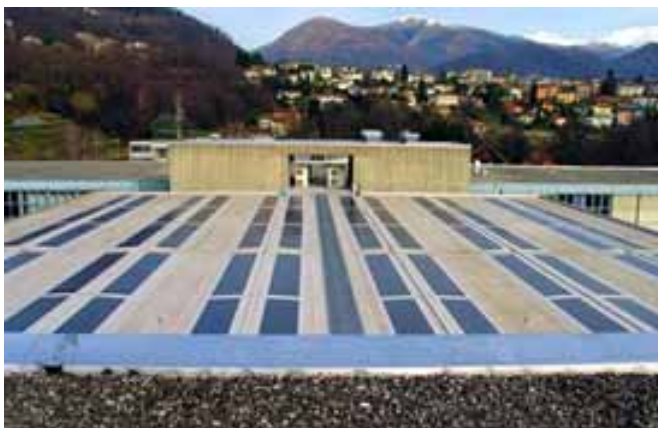
Illustrations 54 et 55: Des solutions d'intégration novatrices produites en Suisse pour les toits du centre professionnel de Trevano (TI) et de la fabrique Flumroc à Flums (SG). Sarnasol Photovoltaik System (exemple de Trevano) soude des stratifiés photovoltaïques flexibles avec des bandes d'étan-
