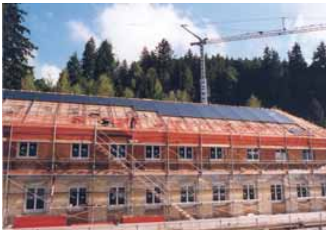
Illustrations 80 et 81: Courant photovoltaïque à Zoug. Montage de l'installation sur le toit de la clinique d'altitude Adelheid à Unterägeri (ZG). Les « Wasserwerke Zug » (WWZ) exploitent cette installation et vendent le courant
