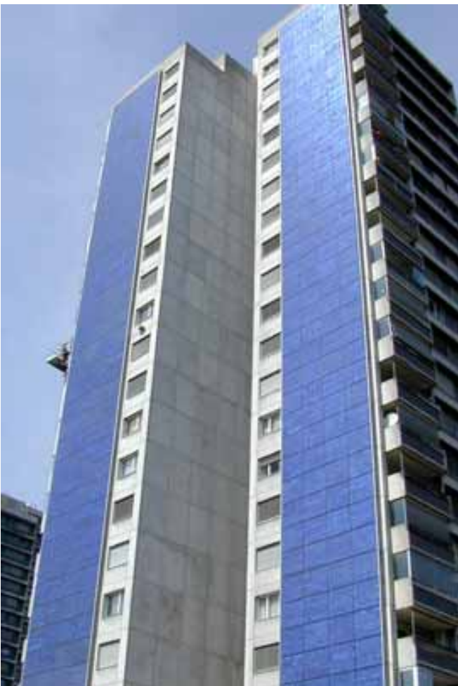
Illustration 35: Le quartier de Wittigkofen à Berne abrite la plus grande centrale solaire d'Europe à être intégrée dans une façade. Elle produit 80 kW de courant pour Energie Wasser Bern (ewb). Source: NET, St-Ours.
