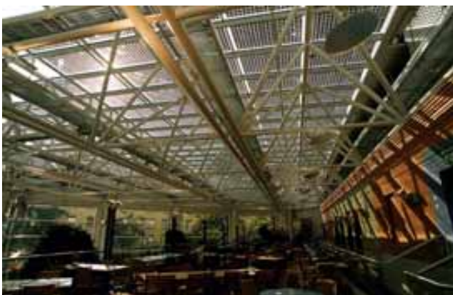
Illustration 76: Une publicité efficace. L'installation de la Migros Limmat à Zurich a été très bien accueillie. Source: energiebüro Zürich.
