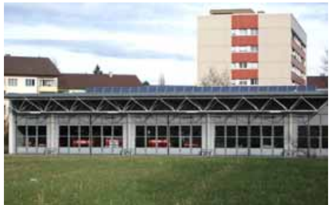
(financièrement) le projet. À Köniz (BE), l'installation photovoltaïque a été posée plutôt discrètement sur le toit plat. Source: Samyn & Partners / R. Schropp, Pays-Bas / M. Gutschner, Fribourg.
