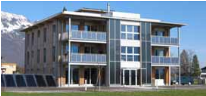
Illustration 37: Minergie et photovoltaïque à Gams (SG). Le bâtiment du « Synergiepark » abrite des bureaux et des ateliers. Ses balustrades de balcon et son toit sont équipés de modules solaires. Source: Heizplan / Synergiepark.
