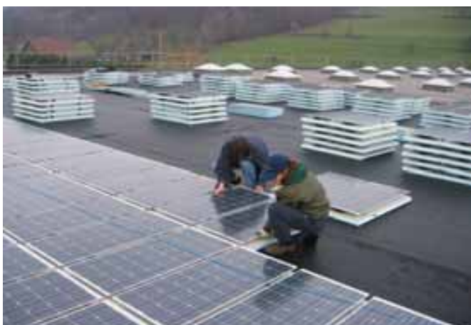
Illustrations 66 et 67: Plaques de couverture solaires. Sur le toit plat de l'entrepôt Trisa à Triengen (LU), des plaques de couverture sont posées pour former une toiture inversée. Ces éléments se composent d'une couche d'isolation
