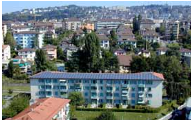
Illustration 34: Immeuble locatif à Lausanne. L'installation de 38 kW produit du courant pour les Services industriels de Lausanne (SIL) et confère un caractère moderne à un immeuble déjà ancien. Source: NET, St-Ours.
