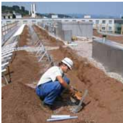
Illustrations 61 à 63: Montage à Pfäffikon (SZ). Les trois étapes du montage d'une installation photovoltaïque (32 kW) sur le toit plat végétalisé de l'immeuble
