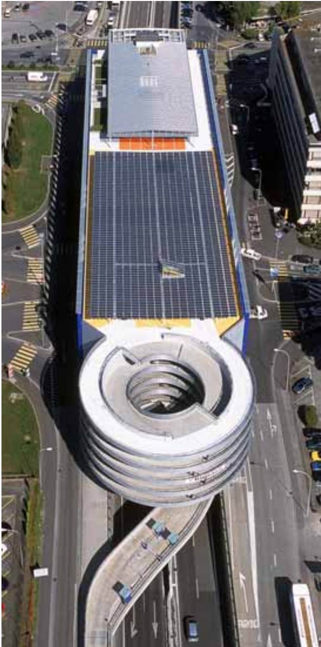
Illustrations 19 à 22: Infrastructures et surfaces urbaines multifonctionnelles. Parking relais: Le toit semi-ouvert du bâtiment du parking relais de Genève produit du courant photovoltaïque (143 kW) pour les Services industriels de Genève (SIG). Source: Sunwatt Bio Énergie, Chêne-Bourg.
