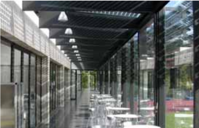
Illustration 23: École cantonale à Stadelhofen (ZH) . Des modules solaires partiellement transparents créent une ambiance particulière en combinant lumière, ombre et production de courant électrique. Source: NET, St-Ours.
