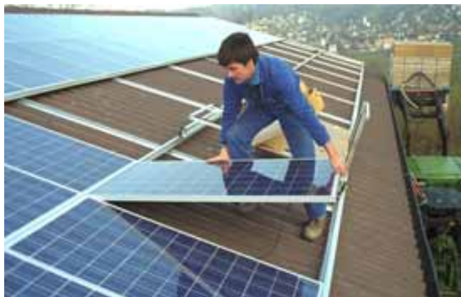
Illustration 121: Solution posée sur le toit. Source: BE Netz, Lucerne.
