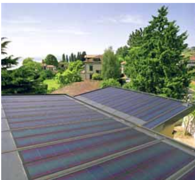
Illustration 124: Intégration au toit « Freestyle » avec des modules incluant la technologie des couches minces à Lutry (VD). Cette maison individuelle neuve a été construite en intégrant des modules avec cellules à couches minces. L'installation de 5,5 kW est invisible depuis le sol. Source: NET, St-Ours.
