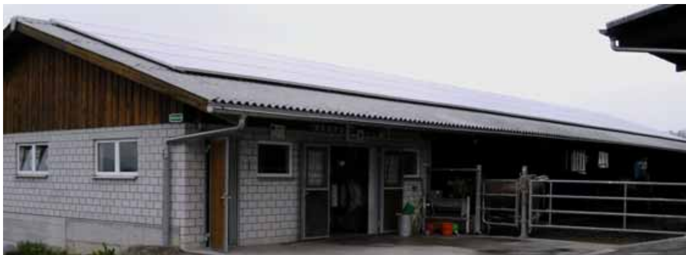
Illustration 94: Installation photovoltaïque sur une étable à Zurich. Avec 120 modules, la plus grande installation de cette campagne solaire peut fournir 19,8 kW. Source: BE Netz, Lucerne.
