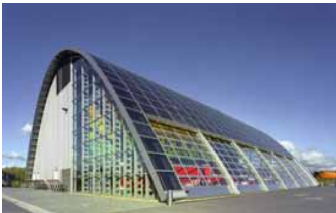
Illustrations 117 et 118: Le photovoltaïque dans sa version manifeste et dans sa version discrète. Comparaison de deux casernes de pompiers. L'architecture particulière du hall de Houten (Pays-Bas) a incité différents acteurs à soutenir
