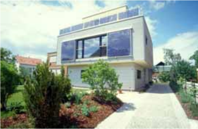
Illustrations 59 et 60: Architecture novatrice combinant la technologie des maisons passives avec du photovoltaïque à Pratteln (BL). Aperçu des enveloppes externe et interne du bâtiment, avec des volets coulissants solaires.
