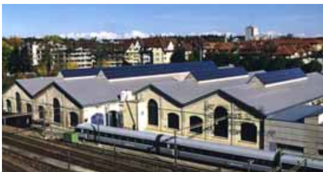
Illustrations 78 et 79: Installations photovoltaïques à Berne. Des installations intégrées aux claires-voies d'un dépôt de locomotives et à des toitures à redans dans le parc industriel de Felsenau produisent respectivement 50 000 et
