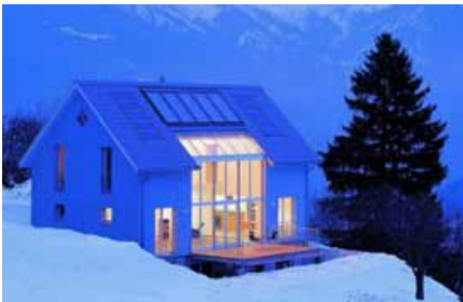
Illustration 50: Maison typique du standard Minergie avec du photovoltaïque et une installation solaire thermique à Malix (GR). Source: ARTHAUS Raum und Linie Rhazüns.
