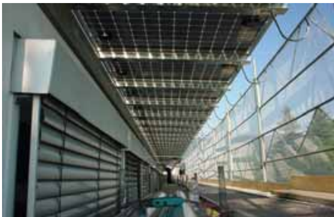
Illustration 57: École d'ingénieurs de Lullier à Jussy (GE). L'installation photovoltaïque constitue aussi un support d'apprentissage concret pour les futurs ingénieurs. Source: Sunwatt Bio Énergie, Chêne-Bourg.
