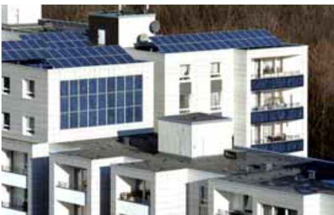
Illustrations 41 et 42: 50 ensembles résidentiels solaires en Rhénanie-du-Nord-Westphalie (Allemagne). Dans ce land, 50 cités solaires caractérisées par une utilisation intensive de l'énergie solaire active et passive seront construites ces prochaines années. Le projet est soutenu par trois ministères du land (urbanisme,
