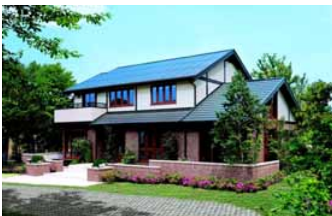
Illustration 122: Solution intégrée à tout un pan de toit. Sekisui House propose une maison japonaise préfabriquée. Pour 21 000 francs supplémentaires, elle peut être équipée d'une installation photovoltaïque de 4 kW et d'un système d'eau chaude très efficace. Source: Sekisui, Japon.
