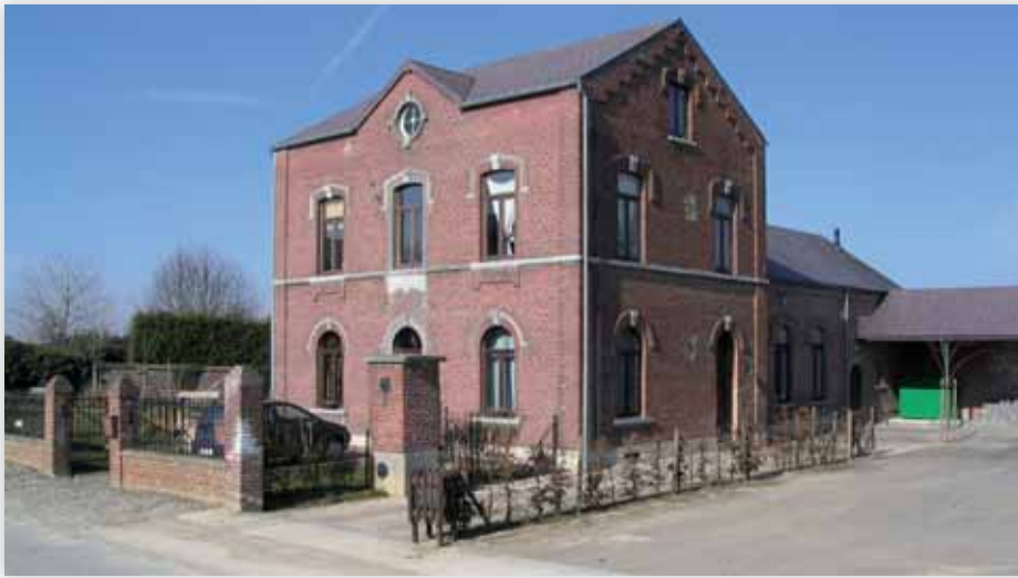
Glimes (Incourt) – deux logements-tremplin dans l'ancienne maison de l'instituteur, rénovée grâce aux subventions de développement rural.
