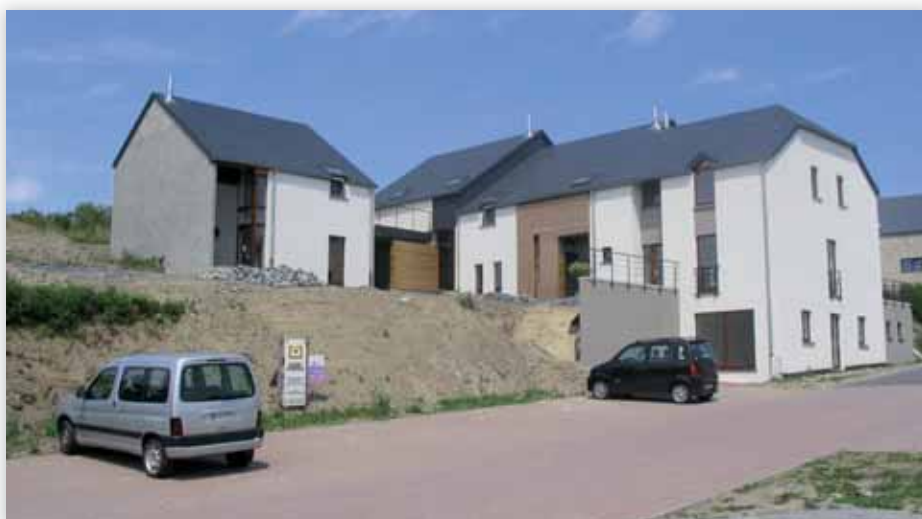
Martelange: 4 logements-tremplin de trois à quatre chambres avec jardin commun et salle polyvalente pour le quartier.
