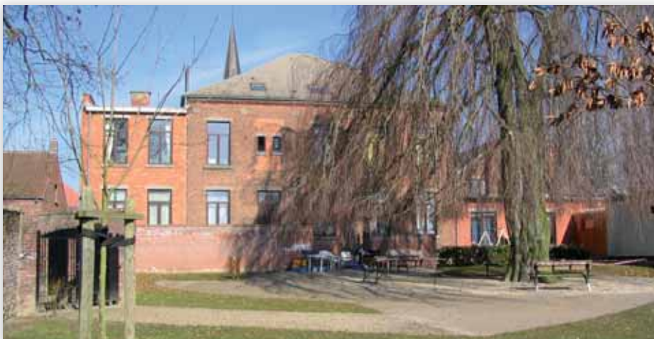
Opprebais (Incourt) – une ancienne gendarmerie aménagée en 4 logements-tremplin via l'opération de développement rural.
