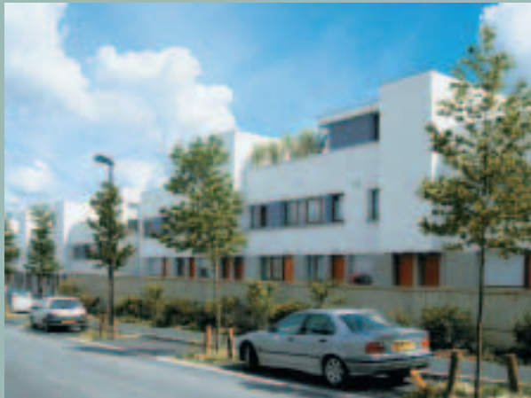
Côté rue, du stationnement longitudinal s'insère entre des alignements d'arbres.
