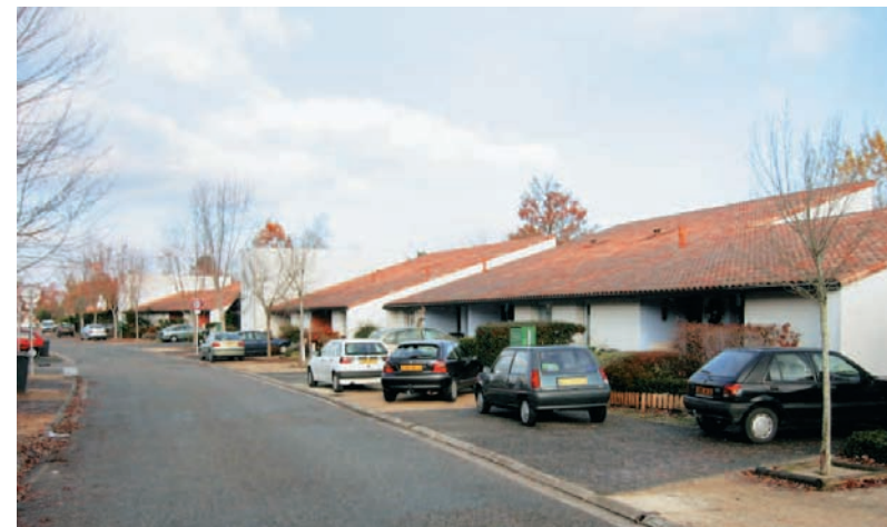
La rue de desserte principale est composée d'une chaussée bordée de larges bas-côtés plantés où le stationnement s'inscrit de manière un peu désordonnée.
