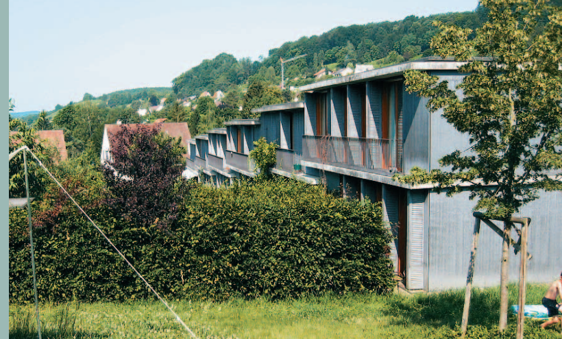
Les maisons, perpendiculaires à la pente, s'ouvrent sur un jardin, au sud.
