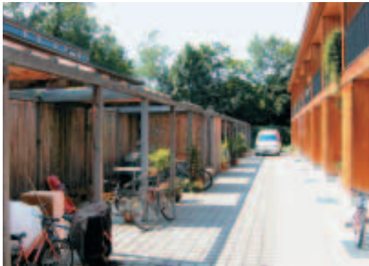
Une venelle entre les remises et les entrées individualisées
