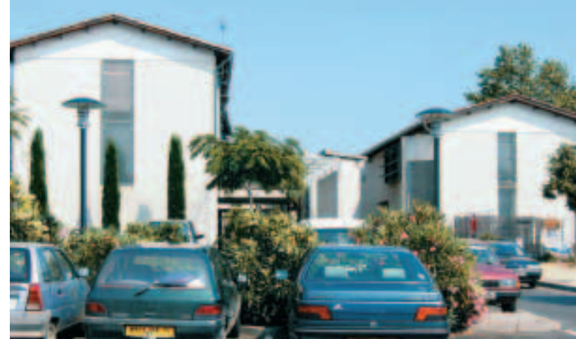
Depuis le parking, dans la perspective de la ruelle centrale
