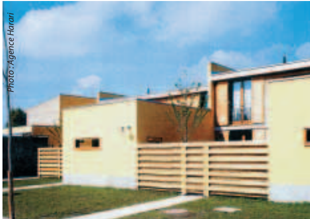
L'alternance des palissades et du bâti
